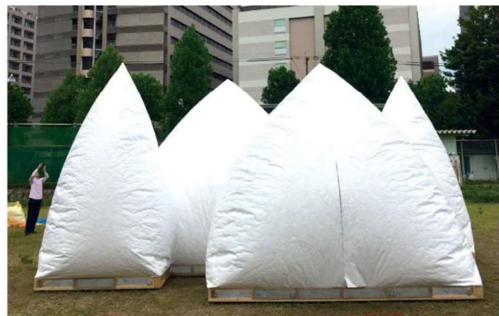
↑ 28.5㎡の仮設住宅の試作（施工時間 約2時間）（2017年7月下旬）
