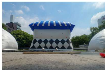
↑幅6m、奥行き4m、高さ4mのキャラクターの試作（施工時間 約1時間）（2018年6月上旬）
