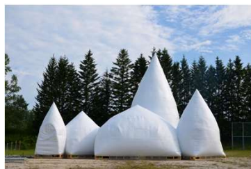
↑70㎡の一般住宅の試作（施工時間 約10時間）（2018年7月下旬）
