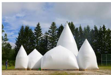
↑70㎡の一般住宅の試作（施工時間 約10時間）（2018年7月下旬）
