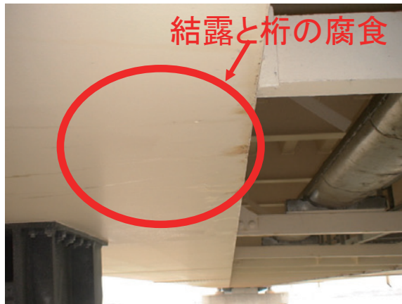
図1. 結露と桁の腐食
