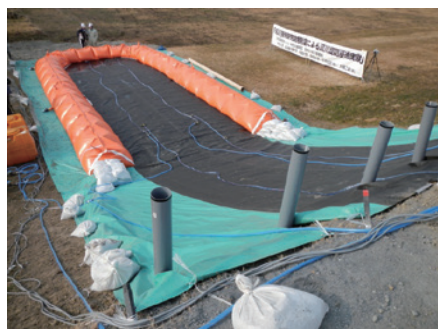
実際の堤防で散水実験を実施
